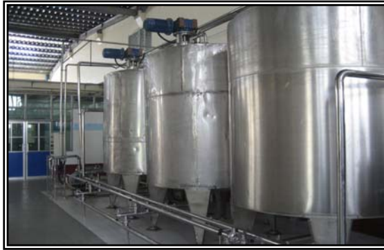
เครื่องจักรในโรงงาน
